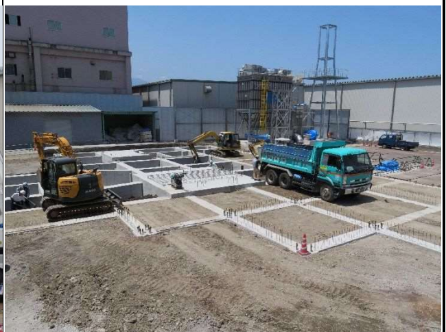
12. 二工区コンクリート埋戻し
