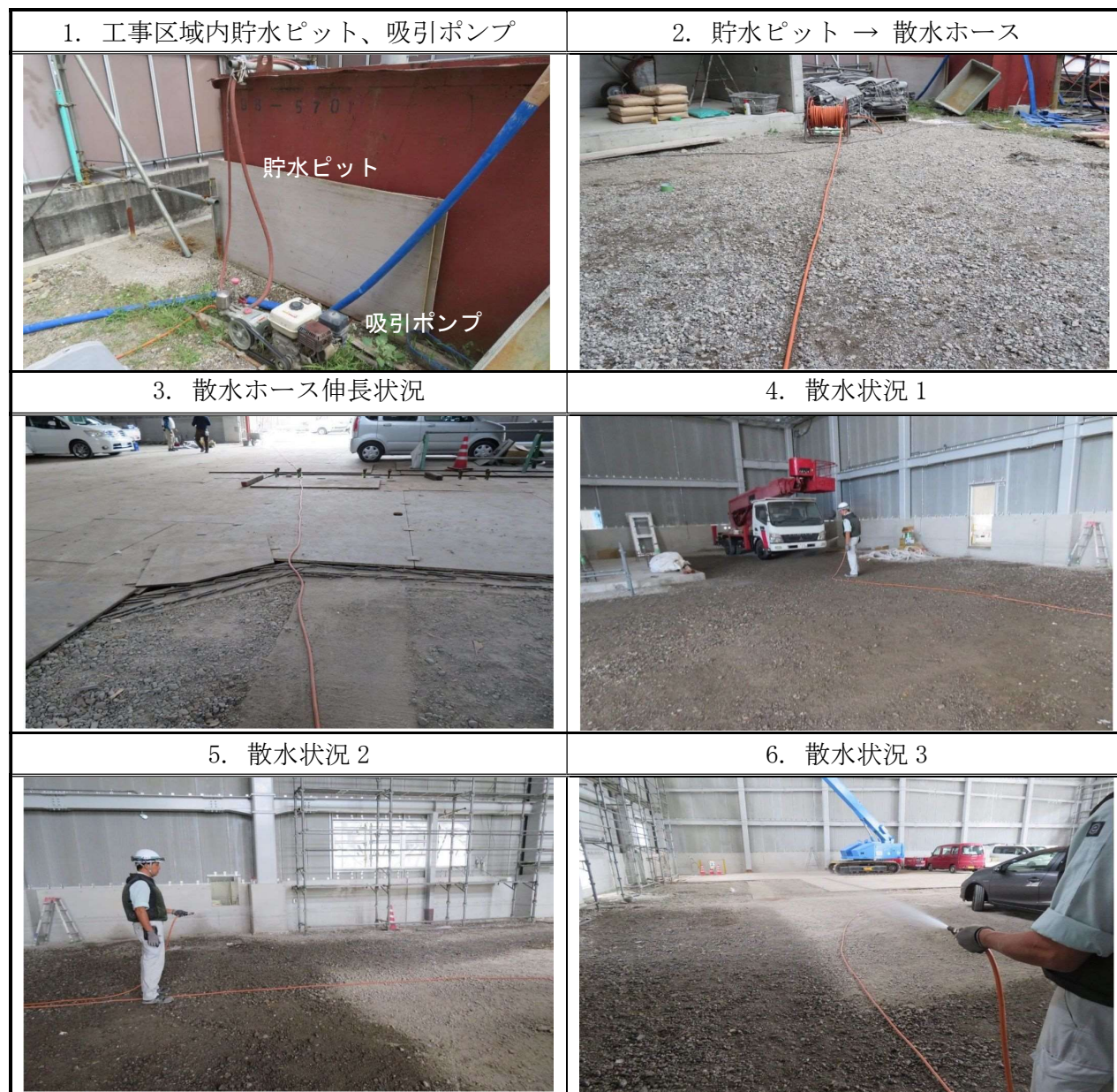
写真 4. 2. 1-3 散水状況
